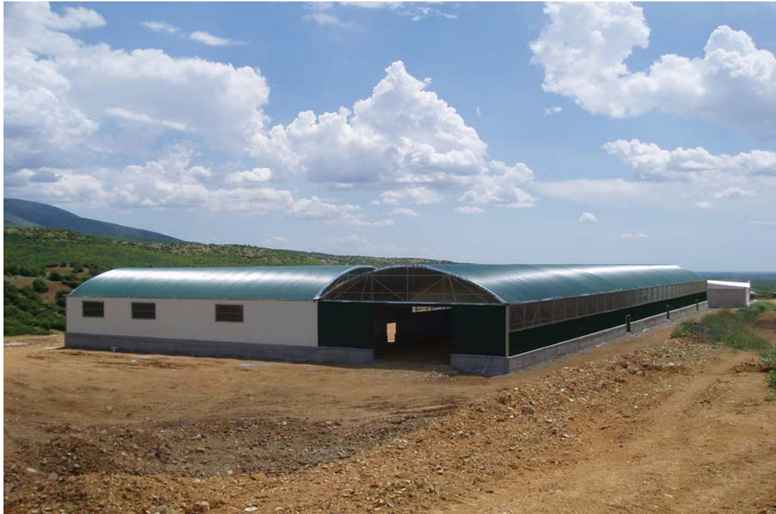
Εικόνα 2. Εγκαταστάσεις θερμοκηπιακού τύπου
